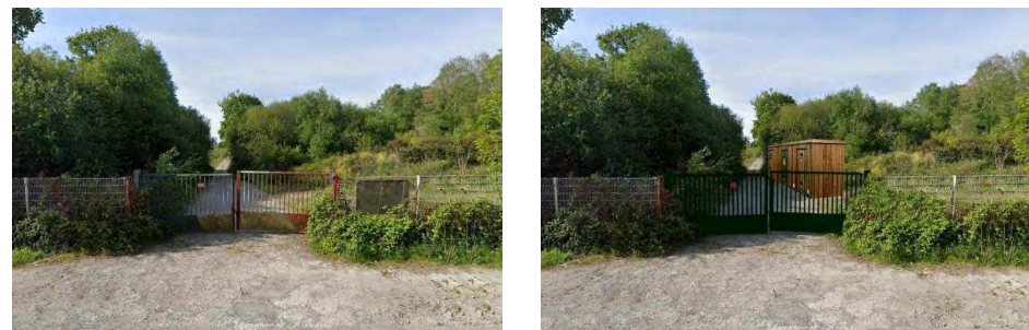
Figure 67 : Entrée du Camp d'Aucaleuc – présence du poste de livraison pour l'injection de l'électricité produite par la centrale photovoltaïque sur le réseau public d'électricité
