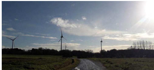
Parc éolien de Lamballe (22) Éoliennes Enercon – 9,2 MW Mise en service en 2011
