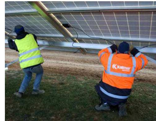
Figure 32 : Câblage des panneaux photovoltaïques
