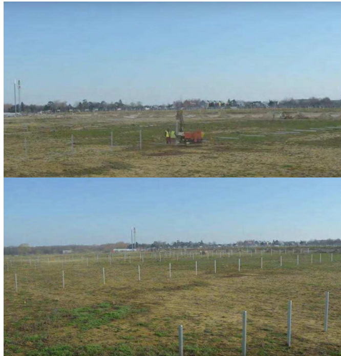
Figure 27 : Mise en place des pieux battus - photos de la construction de la FS Marc Energies, une réalisation IEL
