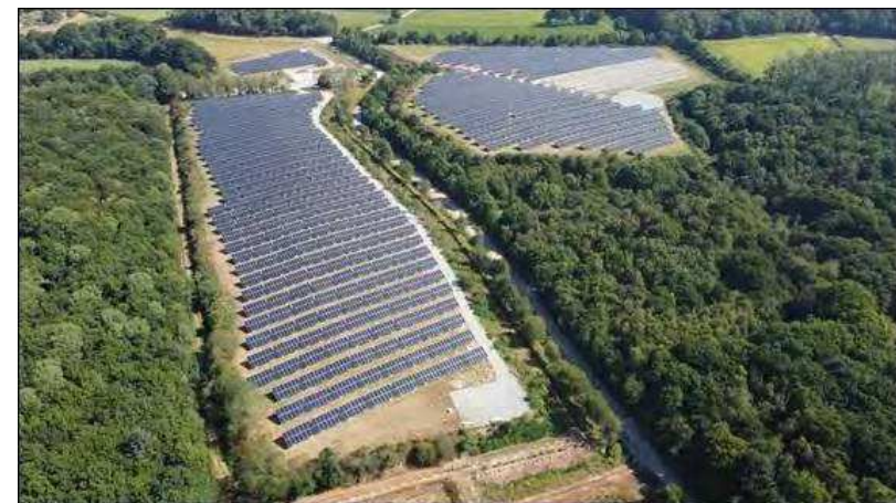
Figure 18 : Centrale photovoltaïque de Ruca, une réalisation IEL (Photo prise en cours de construction)
