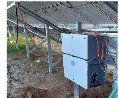
Figure 34 : Onduleurs fixés sur les structures photovoltaïques (FS Beauvoir, photos prises en phase construction, IEL)
