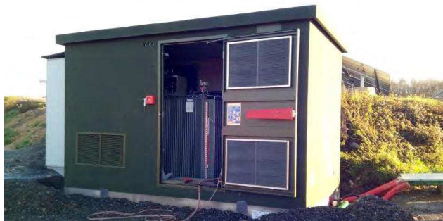
Figure 35 : Poste de transformation d'une centrale photovoltaïque en construction par IEL
