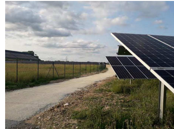
Figure 21 : Clôture mise en place – ferme solaire en construction par IEL
