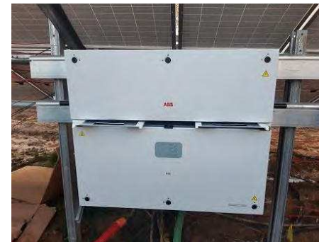
Figure 34 : Onduleurs fixés sur les structures photovoltaïques (FS Beauvoir, photos prises en phase construction, IEL)
